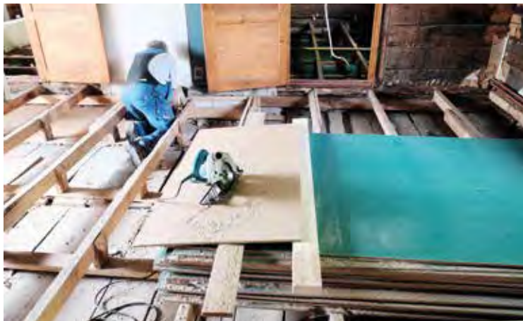
Uutta lattiaa asennettiin Punaiseen taloon kesällä.
