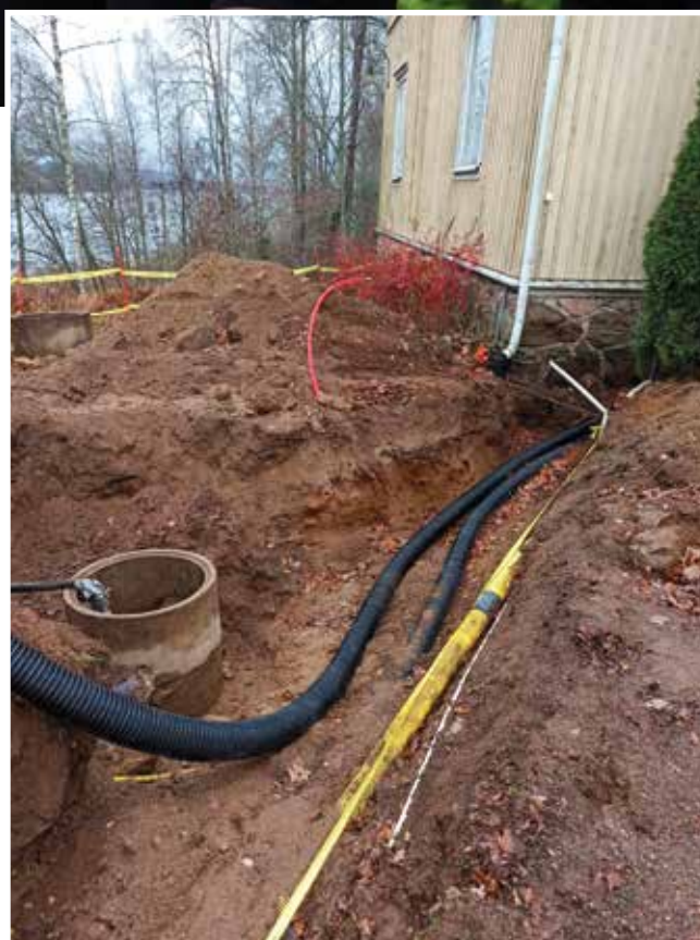
Enä-Sepän lämmitysjärjestelmän uudistamiseen liittyi monia kaivu- ja uudistustöitä.
